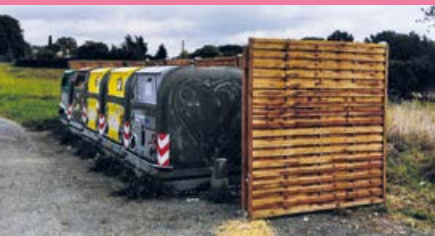
Aménagement au camping de Saint-Alvère réalisé par les équipes de la maintenance du patrimoine
