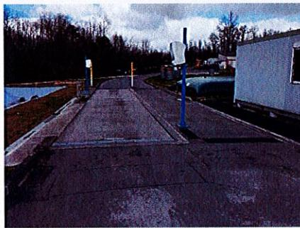
L'entrée directe vers le centre de transfert, via le pont bascule 18 mètres, lui aussi relié au logiciel de pesée Winstar, et équipé de bornes pour la pesée automatique par badge. Ce pont a été mis en place pour gérer l'ensemble des flux entrants et sortants du centre de transfert et de l'ISDI.
